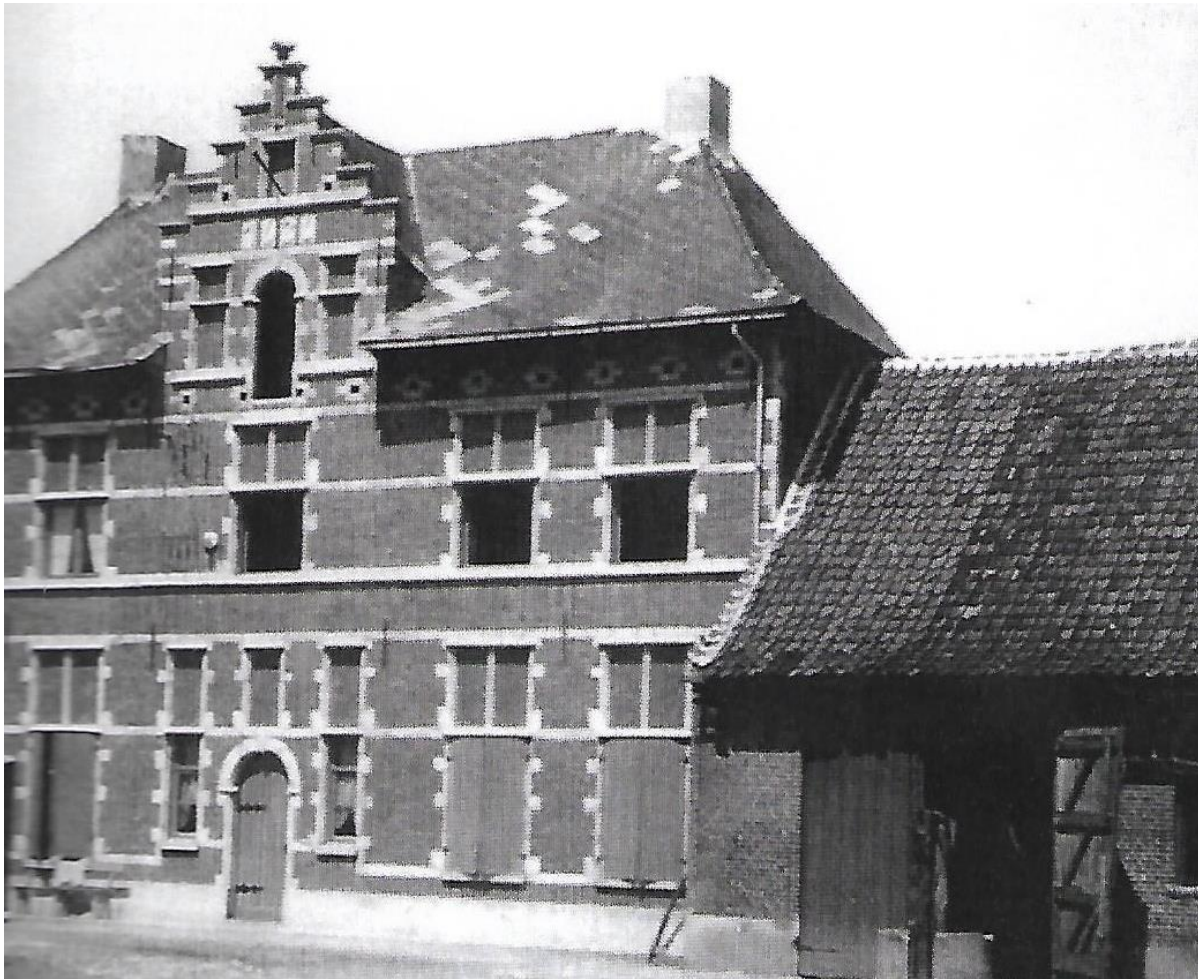
De grote Slijkenhoeve vóór de restauratie (Slijkenhoevestraat)
